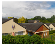
École élémentaire Noël du Fail
